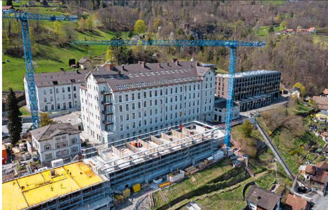
10 000 Quadratmeter Wohnfläche: Die frühere Stoffel-Spinnerei (grosses Gebäude in der Bildmitte) ist fast fertig umgenutzt – die ersten Wohnungen sind bezugsbereit.
