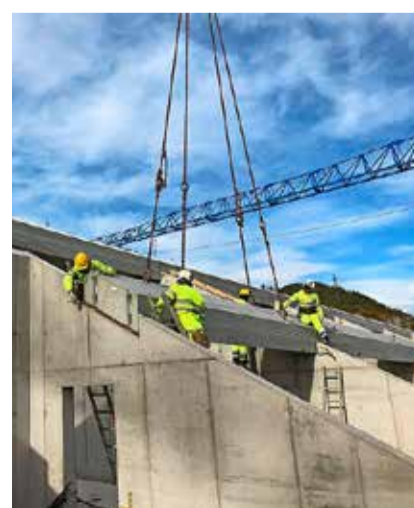
Dachpfetten aus Beton: Der 500-Tonnen Pneukran hat 26 Elemente mit 220 Tonnen Gesamtgewicht auf die Spinnerei gehoben. Pressebilder
