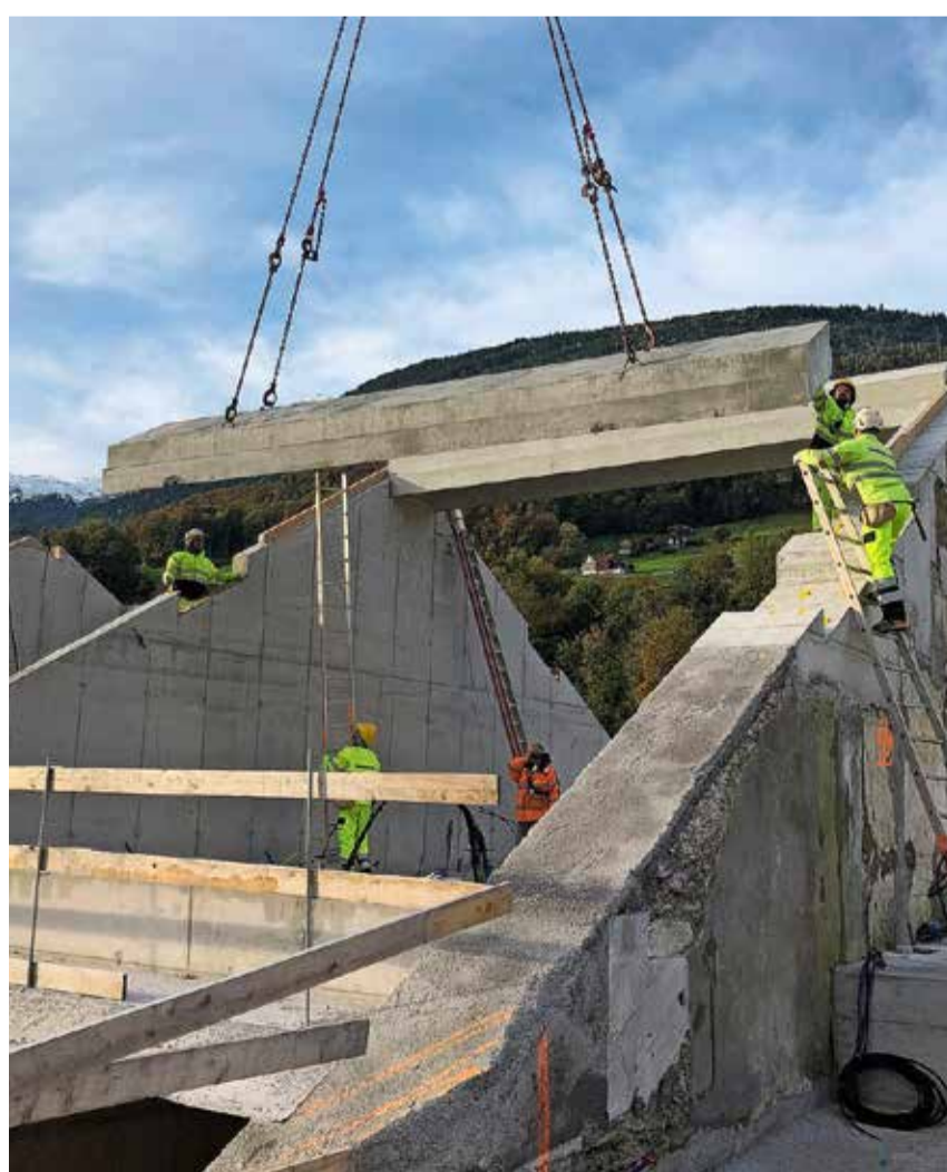
Dachpfetten aus Beton: Der 500-Tonnen Pneukran hat 26 Elemente mit 220 Tonnen Gesamtgewicht auf die Spinnerei gehoben. Pressebilder
