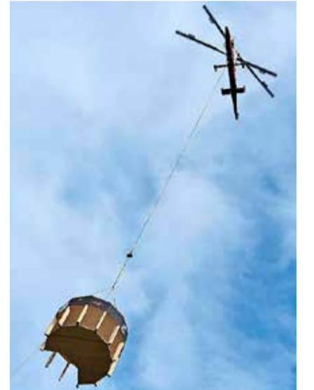
Der Ernstfall: Während Dario Jäger, Geschäftsführer der Jäger Holzbau AG, alles mit seinem Smartphone festhält, treffen seine Arbeiter die letzten Vorbereitungen am Gerüst. Ein K-Max der Rotex Helikopter AG transportiert die Elemente.
