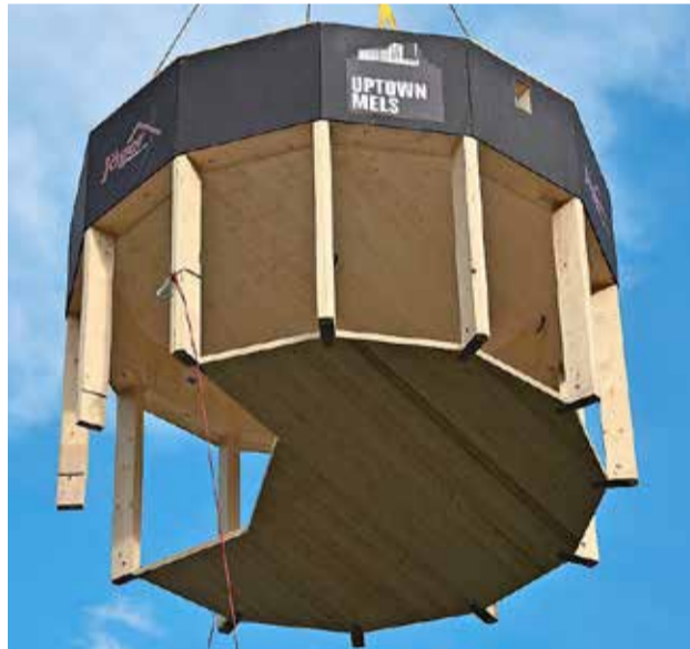
Eines von zwei Turmelementen: Ein Gewicht von bis zu 2,8 Tonnen muss der Hubschrauber tragen können.
