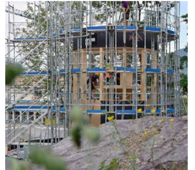
Feinschliff nach dem Flug: Am Ende müssen die beiden Elemente präzise aufeinander abgestimmt werden.
